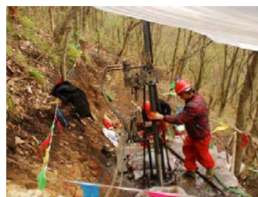
浅钻施工现场
